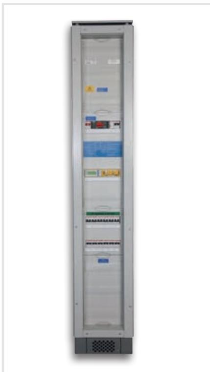
S-IPS-F/EDS con ATICS® equipo de conmutación automática y vigilancia y localizador de fallos de aislamiento
